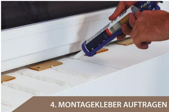
Geben Sie den Montagekleber in vertikalen Streifen (nicht punktförmig!) von 2-3cm Dicke aus. Der Abstand der Streifen sollte etwa 10-20cm betragen.
