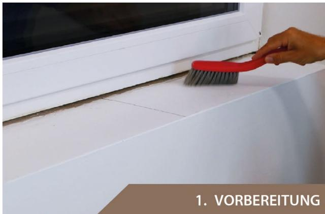
Reinigen Sie die Fensterlaibung. Der Untergrund muss trocken und frei von Staub sein.
