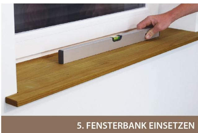
Legen Sie die Fensterbank vorsichtig von oben ein. Benutzen Sie eine Wasserwaage, um die Fensterbank mit etwas Druck auszurichten. Sie sollte vollständig auf die Ausgleichshölzer aufliegen. Diese werden nicht entfernt.
