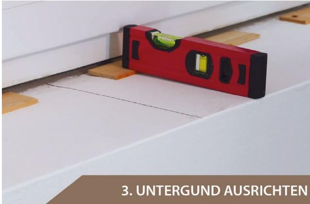
Benutzen Sie verschieden hohe Ausgleichsklötzchen und eine Wasserwaage, um den Untergrund gerade auszurichten. Bei einer Innenfensterbank benötigen Sie kein Gefälle.
